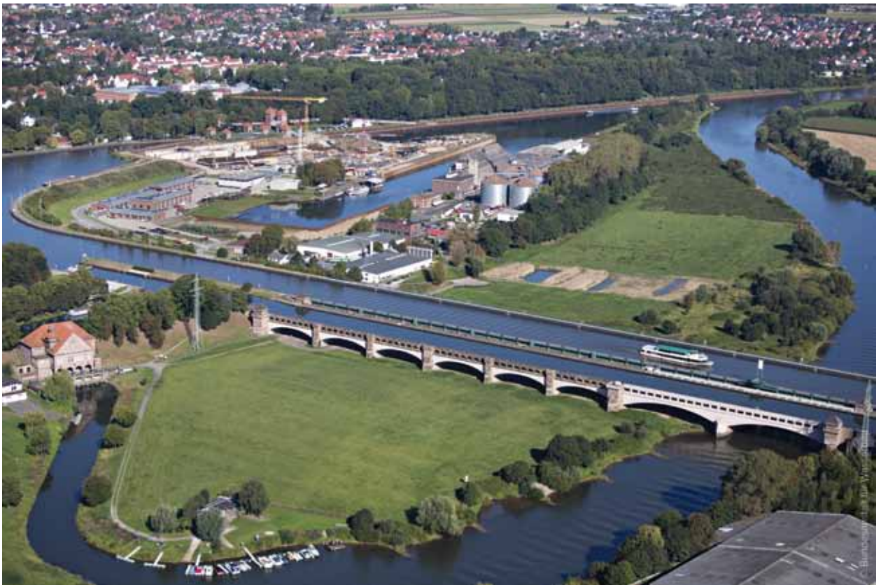
Bau der Weserschleuse Minden
