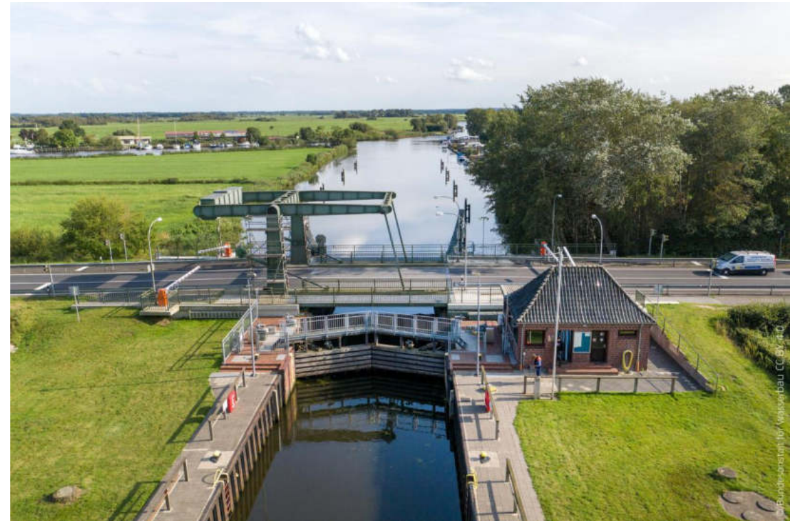
© Bundesanstalt für Wasserbau
