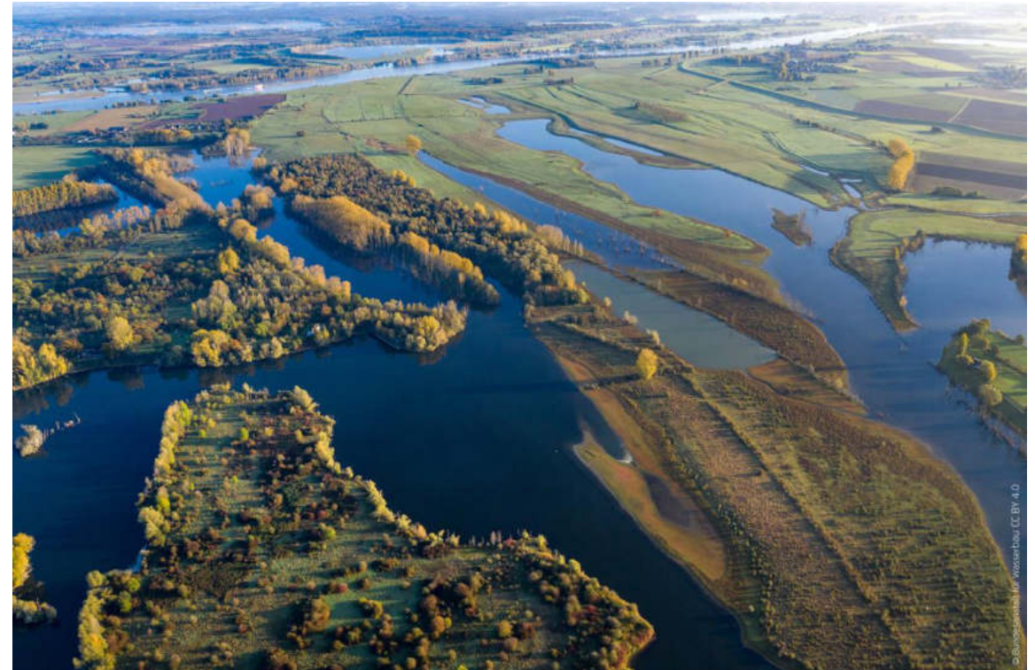
© Bundesanstalt für Wasserbau
